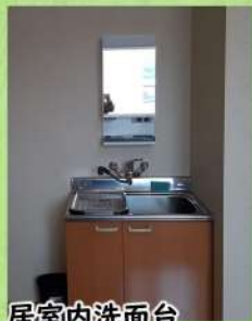
居室内洗面台
