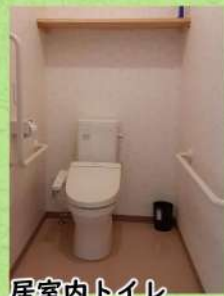
居室内トイレ
